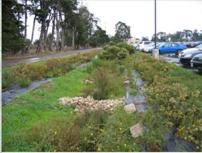
dlo rigol: 'bioswale'
